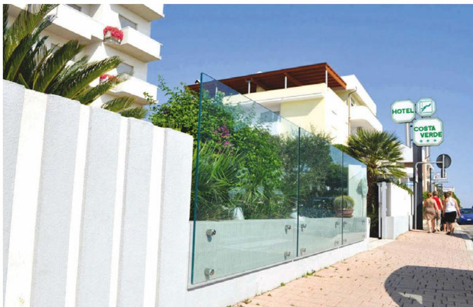
eredità della famiglia di balaustre in acciaio e vetro della gamma Ninfa sono l'assenza di ponti termici, la rapidità di montaggio e l'essere antisismico.
